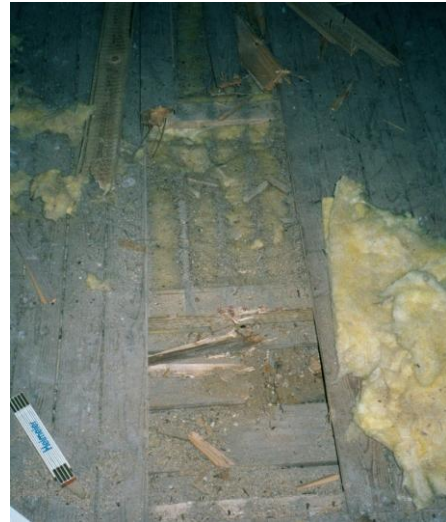
Künstliche Mineralfasern in Zwischendecken
